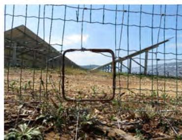
La mise en place de cadres en fer au niveau de ces trous est important pour renforcer le dispositif sur un temps long.
