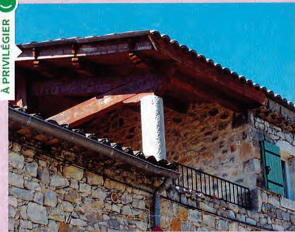
*L'implantation de la terrasse dans le prolongement de la toiture existante, avec mise en place d'une charpente traditionnelle en bois et d'une couverture en tuiles, est une solution adaptée au centre ancien. Le garde-corps présente un motif simple ; il reste discret dans la perception générale. L'ensemble offre une simplicité volumétrique en harmonie avec la partie existante.*
