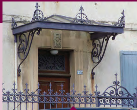
Marquise et grille
