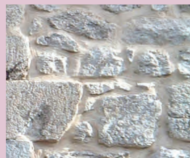
Joints à la chaux
