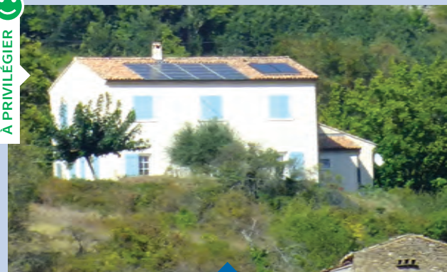
Panneaux intégrés à la pente du toit
