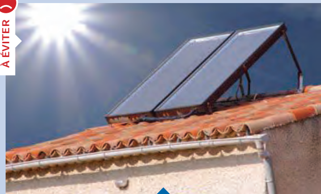
Panneaux rajoutés sur la toiture et non intégrés à la pente du toit
