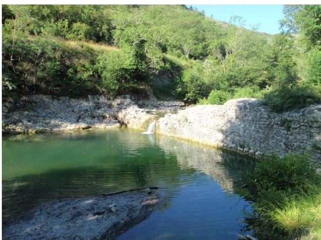
Muré en pierres sur le Lavezon dans le Sud-Est de la commune. L'écoulement permet l'oxygénation de l'eau. En aval du muré, l'eau stagne et forme une large étendue non courante.
