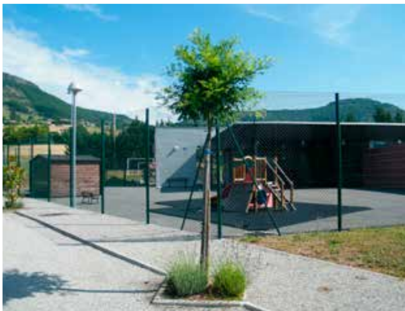
Rehaussement et renforcement du grillage de la cour de l'école.
